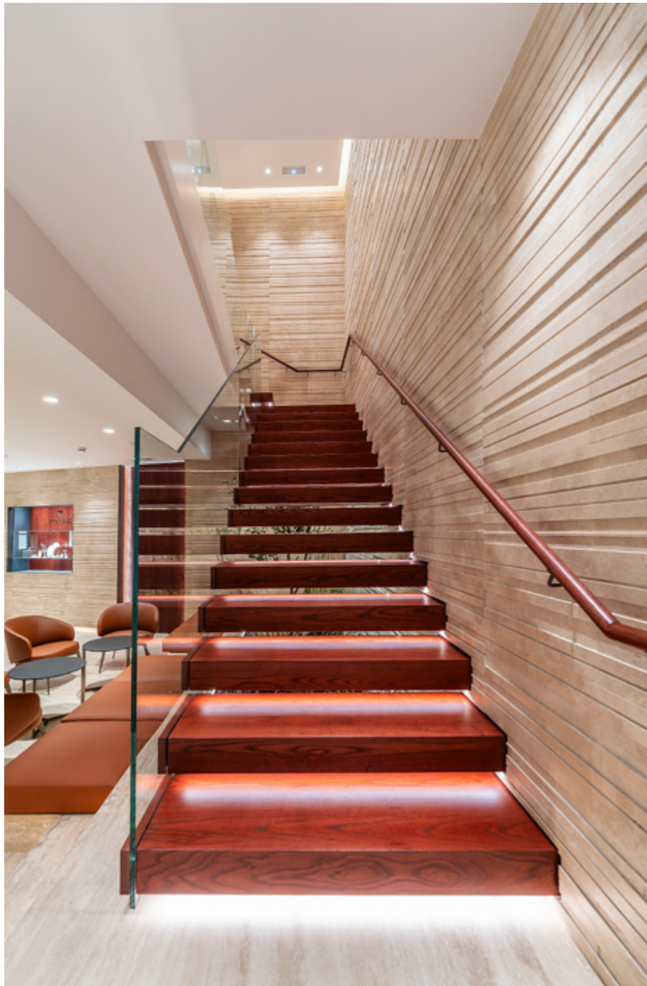
▲ L'escala que ens porta a la planta inferior s'ha construït amb graons volats de fusta (amb ànima de tub ferro) i llum led inferior.
