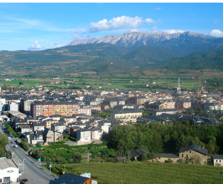
▲ Vista general de la Seu d'Urgell (Viquipèdia)
