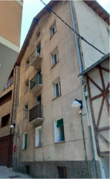
► Dues vistes de la façana sud, al carrer Caballers. Abans i després de la intervenció.
