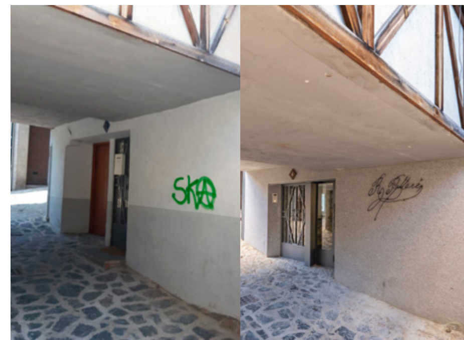
► Dues vistes de la façana est, al carrer Caballers. Abans i després de la intervenció.
