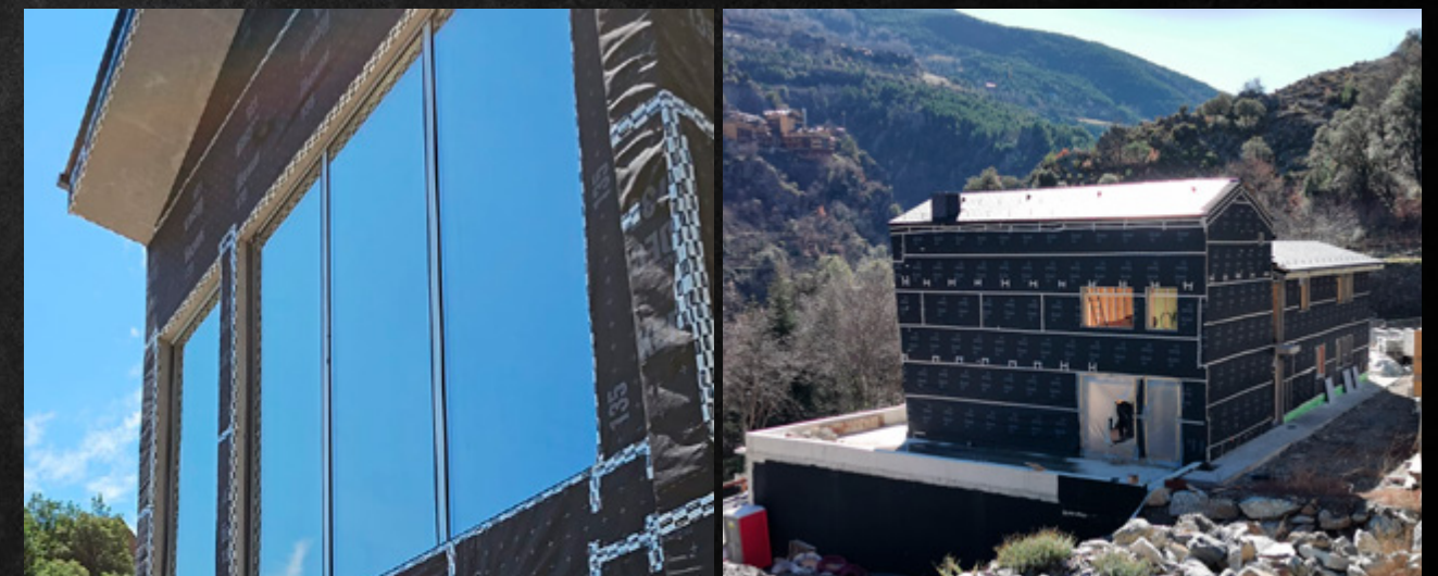
▲ Obra amb sistema prefabricat lleuger de fusta, sistema domeHaus
