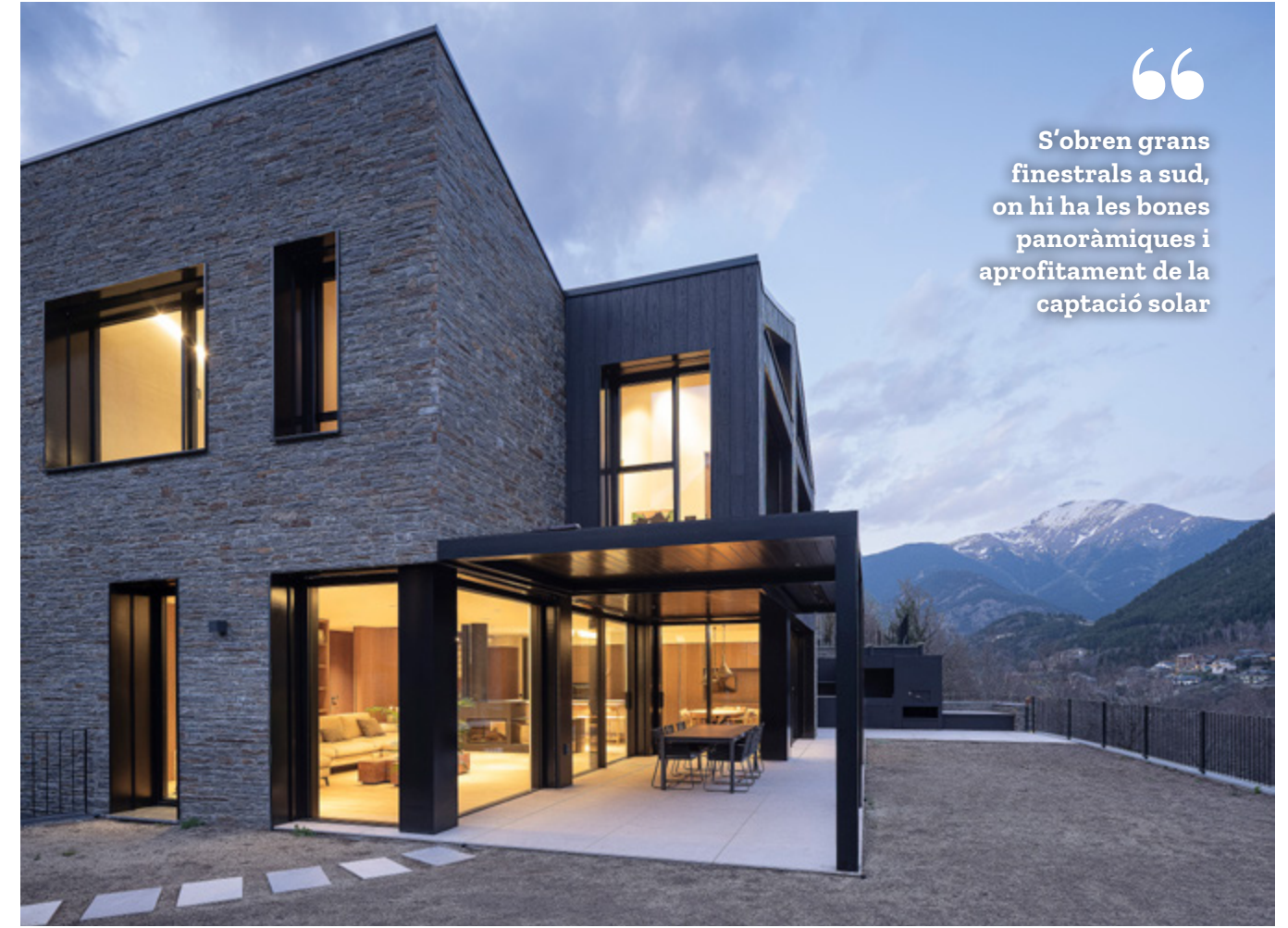
▼ Es fan façanes molt opaques a les orientacions a nord per evitar les pèrdues energètiques i controlar les visuals cap als veïns.
