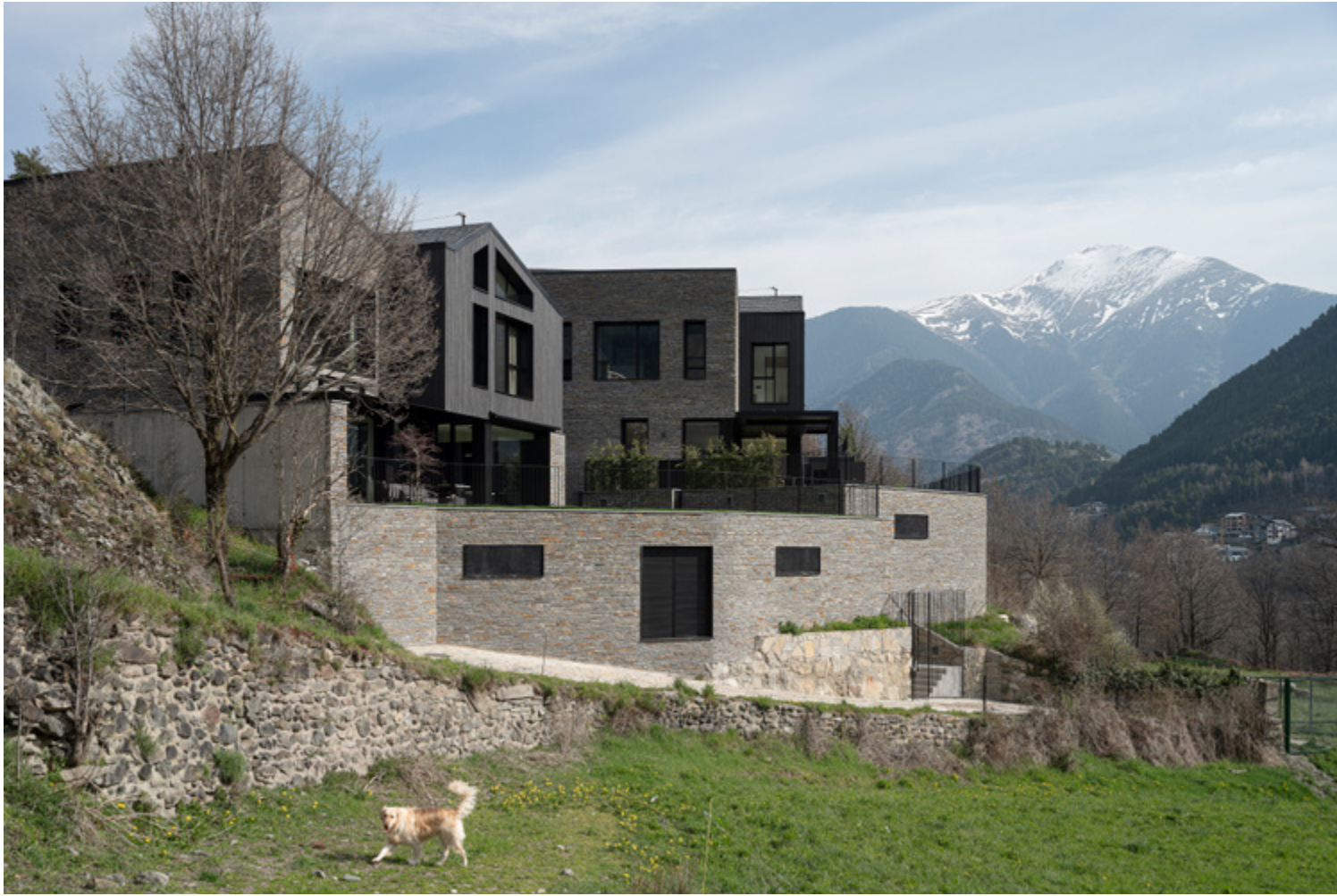
▲ Les cases es van esglaonant en cascada per adaptar-les a la topografia original del terreny.
