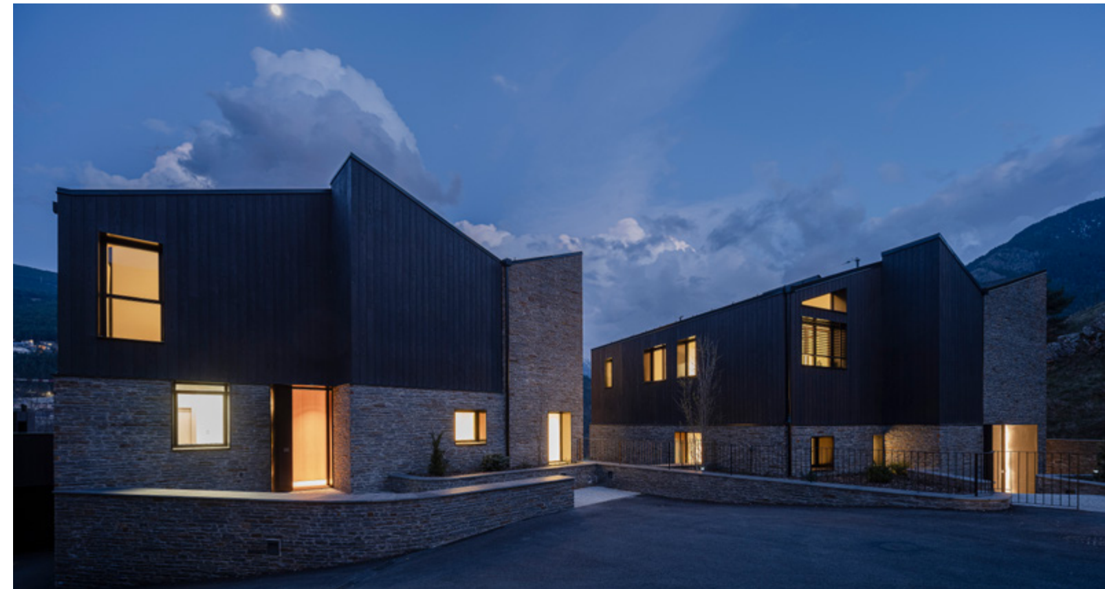
▼ Es fan façanes molt opaques a les orientacions a nord per evitar les pèrdues energètiques i controlar les visuals cap als veïns.
